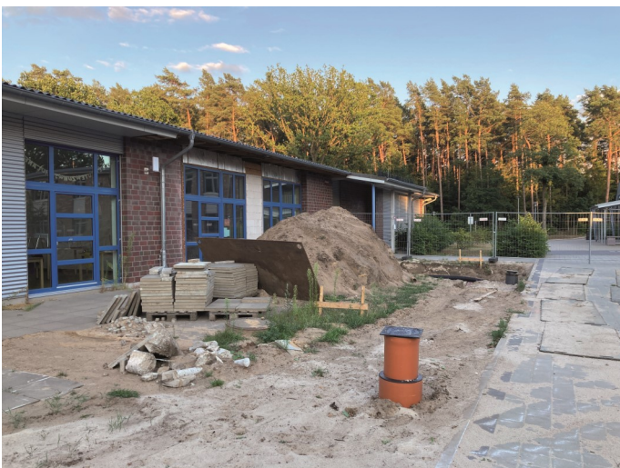
Baustelle Erweiterung Waldschule
